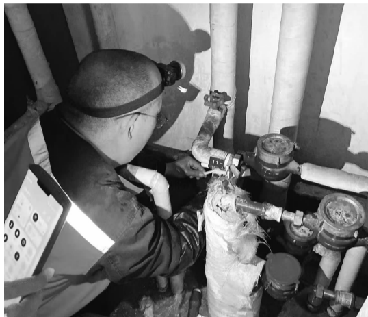
▲维修破裂管道
